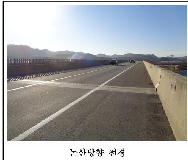
【사진 3.42】 교면포장 전경
