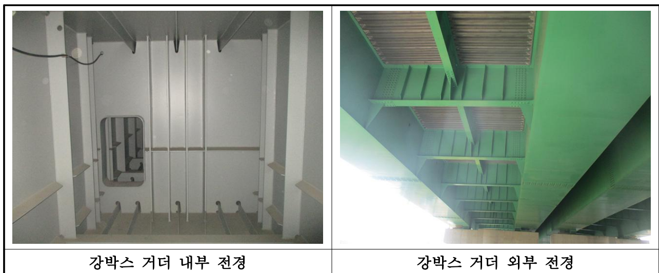
【사진 3.4】 강박스 거더 전경
