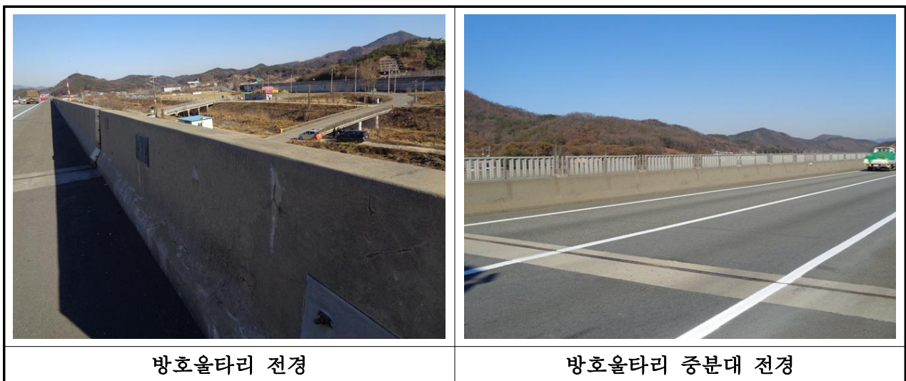
【사진 3.46】 난간 및 연석 전경
