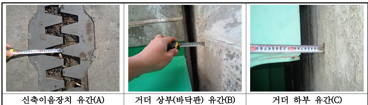
【사진 3.41】 신축이음 유간 측정방법
