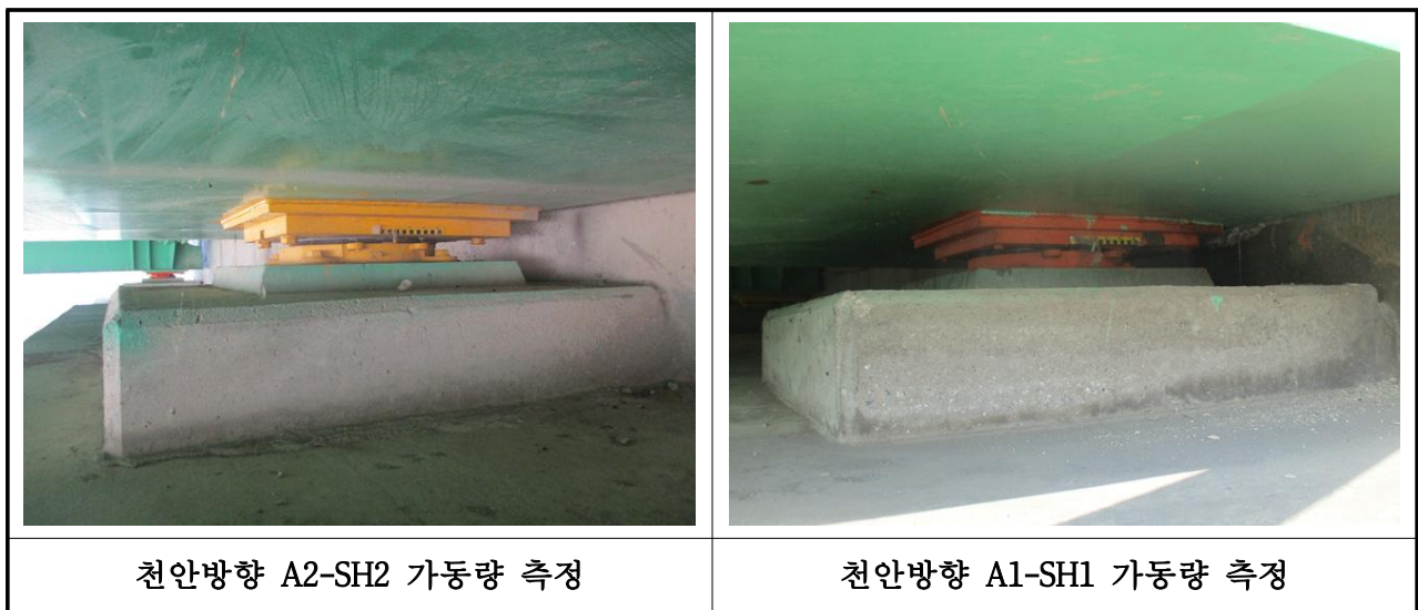
【사진 3.15】교량받침 가동량 측정 전경
