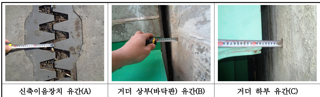
【사진 3.18】 신축이음 유간 측정방법
