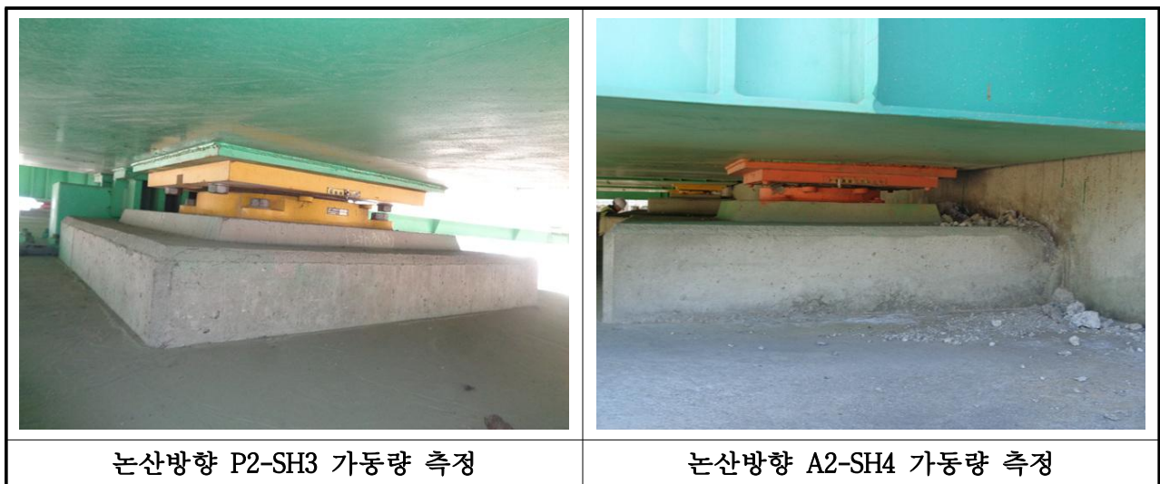
【사진 3.38】교량받침 가동량 측정 전경
