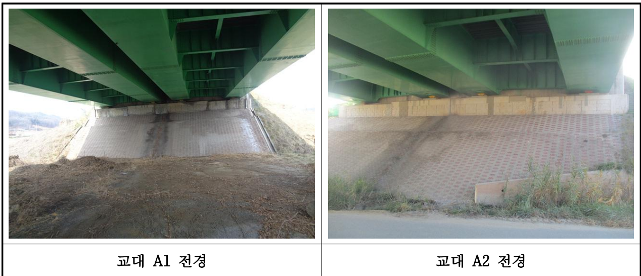
【사진 3.9】 교대 전경
