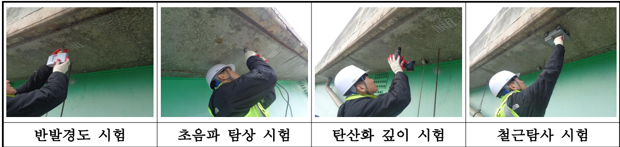
【사진 3.48】 콘크리트 내구성조사 전경
