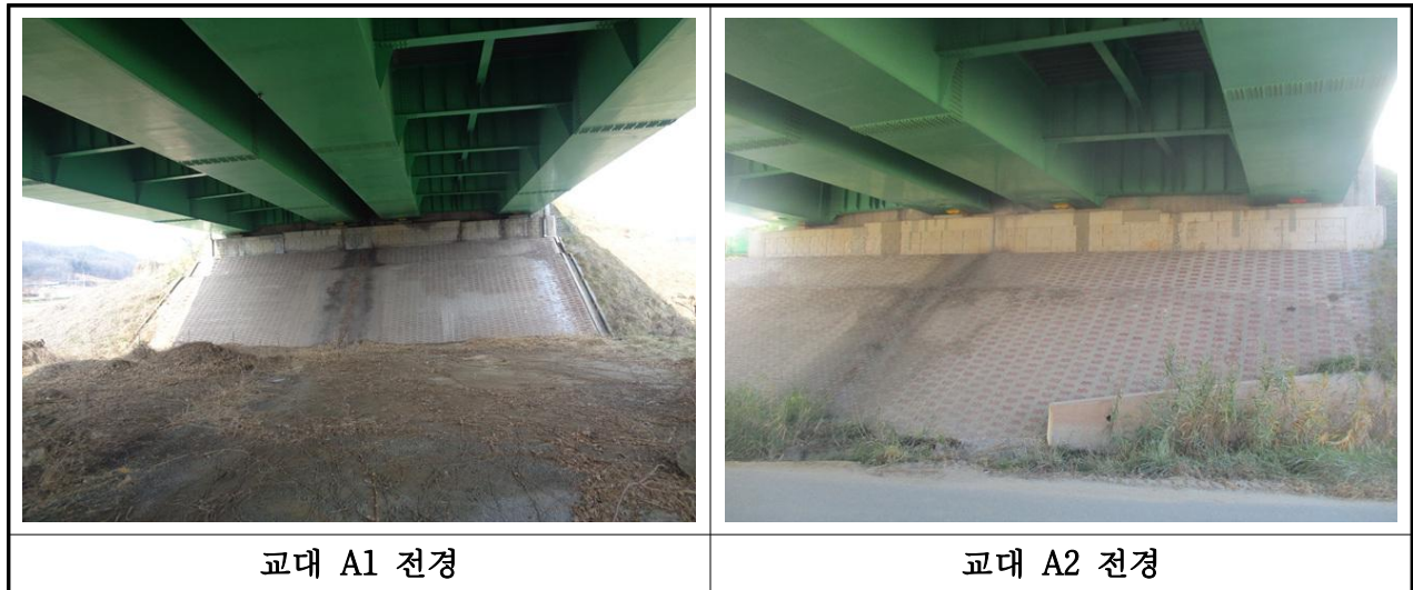
【사진 3.32】 교대 전경
