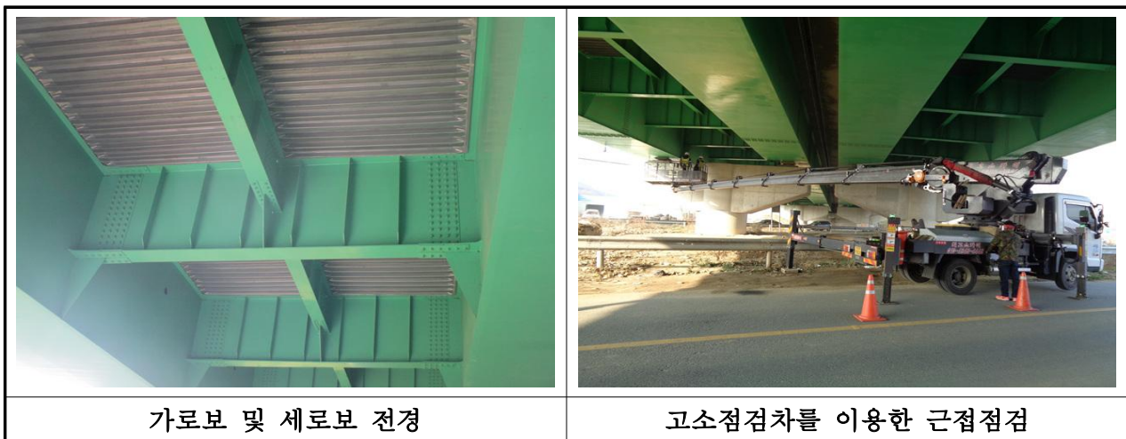
【사진 3.30】 가로보 및 세로보 전경
