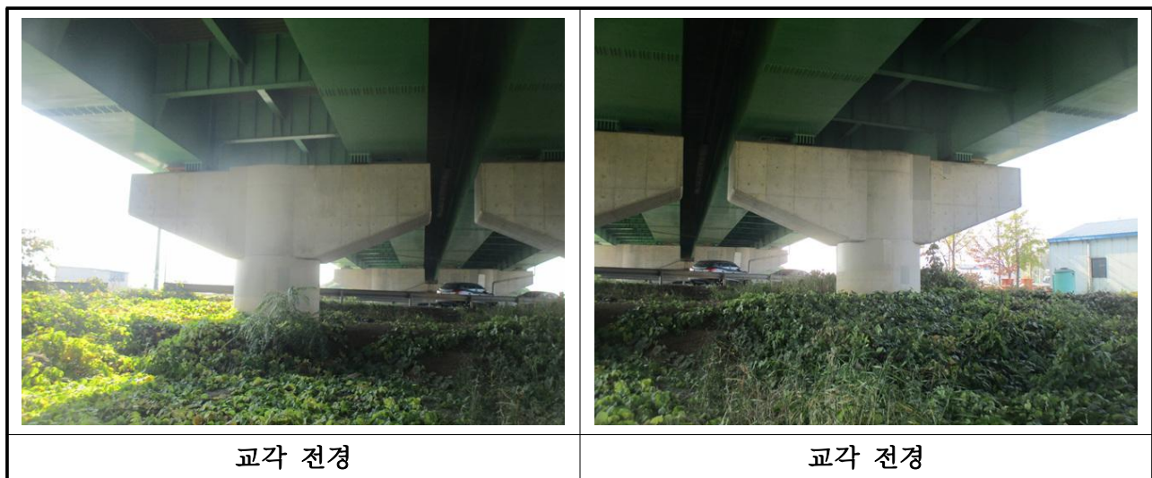
【사진 3.34】 교각 전경
