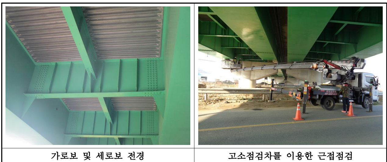
【사진 3.7】 가로보 및 세로보 전경
