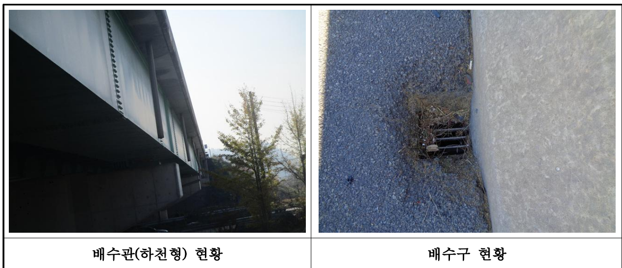
【사진 3.21】 배수구 및 배수관 전경
