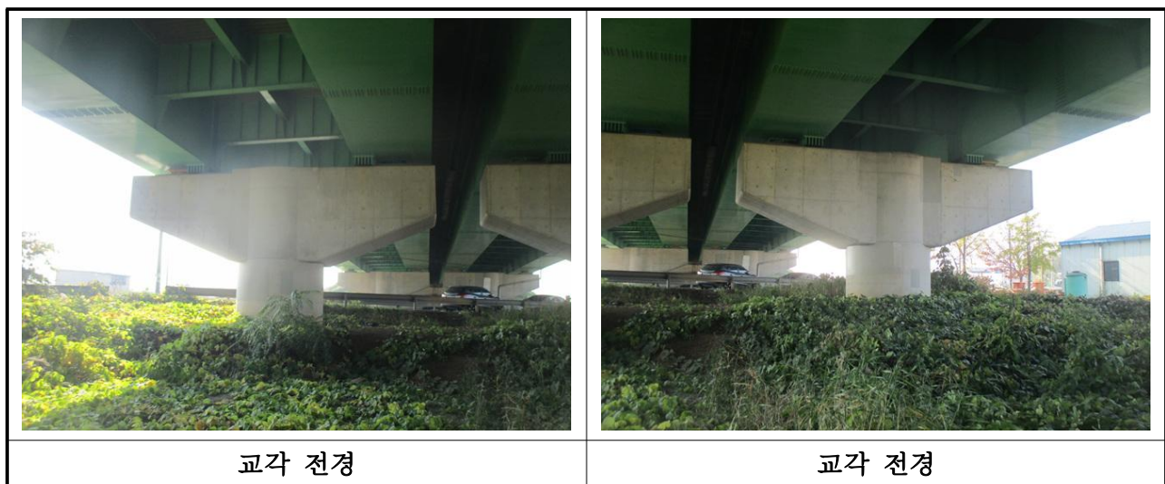
【사진 3.11】 교각 전경
