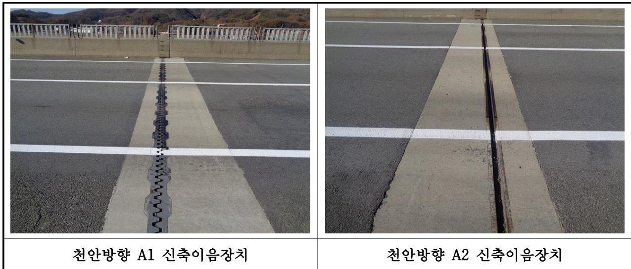
【사진 3.16】 신축이음장치 전경
