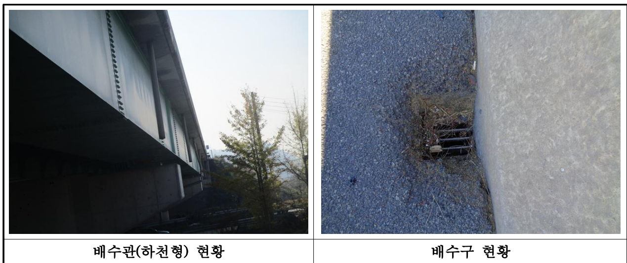
【사진 3.44】 배수구 및 배수관 전경
