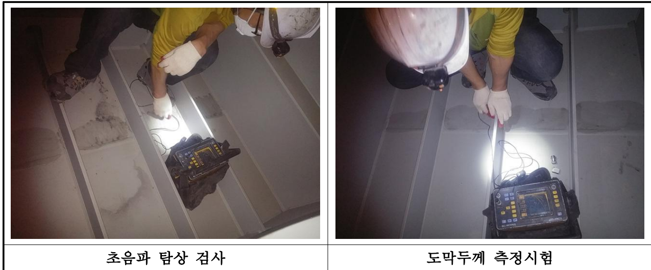
【사진 3.49】 강재 내구성조사 전경
